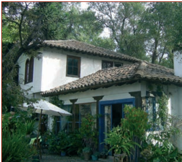
Pesebreras antiguas de Aculeo - hoy vivienda - Se mantienen las argollas en que se amarraban potros
